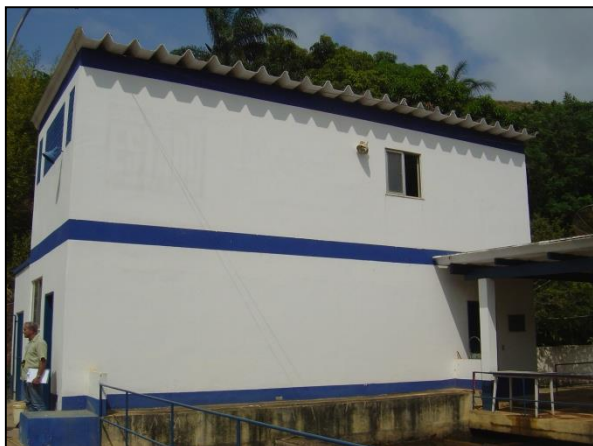
Figura 13 – Vista 1 da ETA Paty
