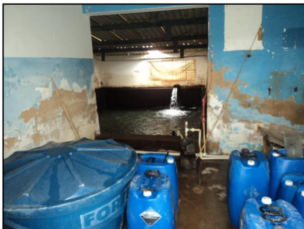
Figura 25 – Reservatório ETA Avelar
