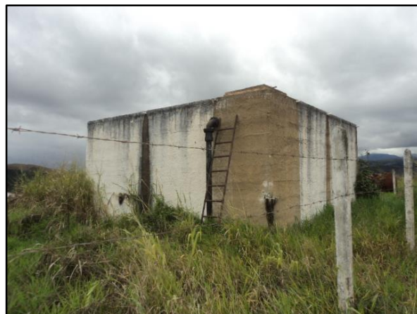
Figura 26 – Reservatório do Morro João Malandro
