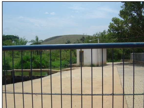
Figura 10 – Estação elevatória de água bruta
