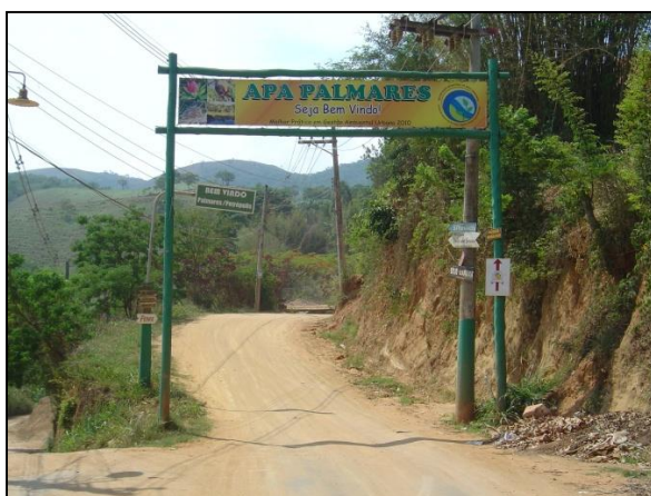
Figura 35 – Rua sem asfaltamento e sistema de drenagem
