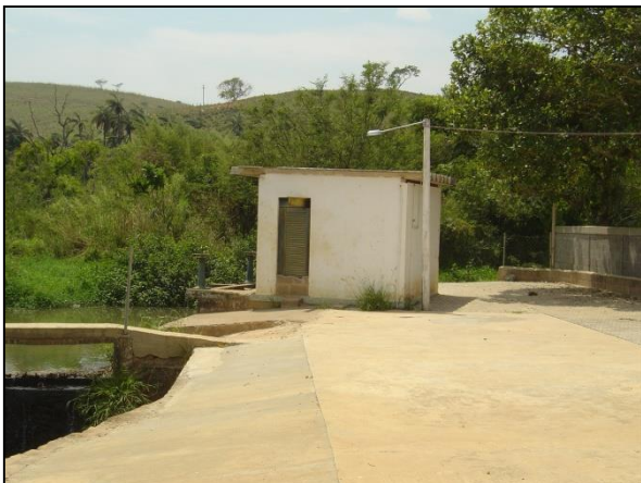
Figura 9 – Estação elevatória de água bruta
