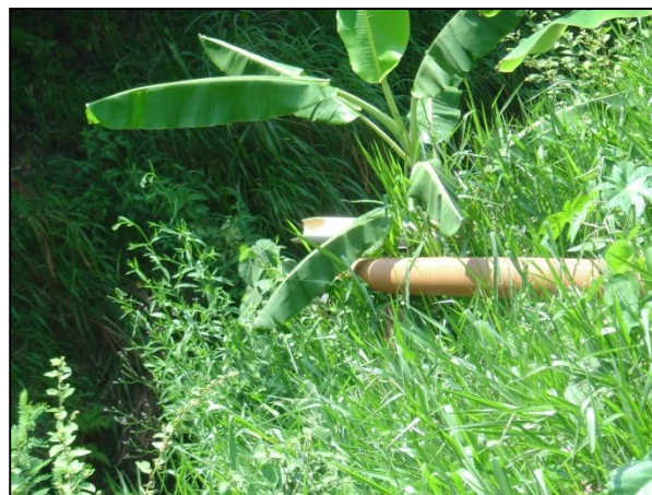
Figura 32 – Saída de esgoto in natura da ETE desativada no Rio Ubá
