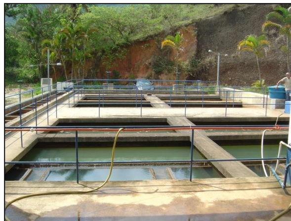
Figura 14 – Vista 2 da ETA Paty
